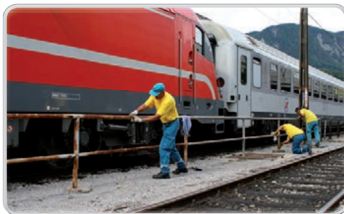
Železničarji v akciji
