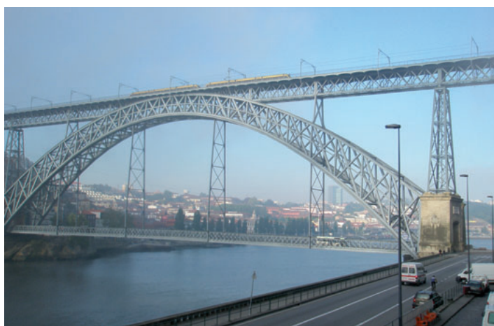
Železni most Dom Luis, v Portu, ki poteka čez reko Douro
