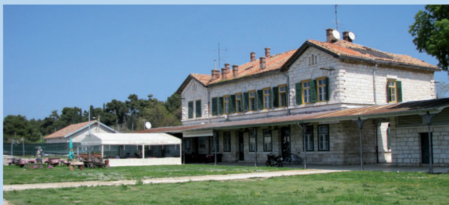
Postajno poslopje Rovinj, kjer sta danes fitnes in gostinski center.
