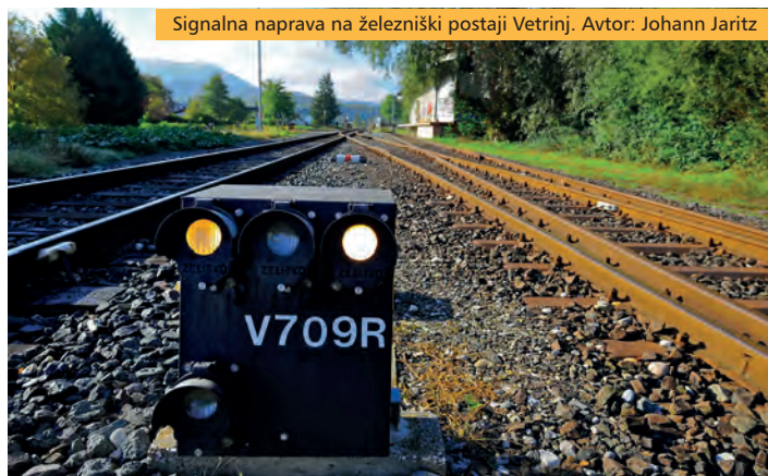
Signalna naprava na železniški postaji Vetrinj. Avtor: Johann Jaritz
