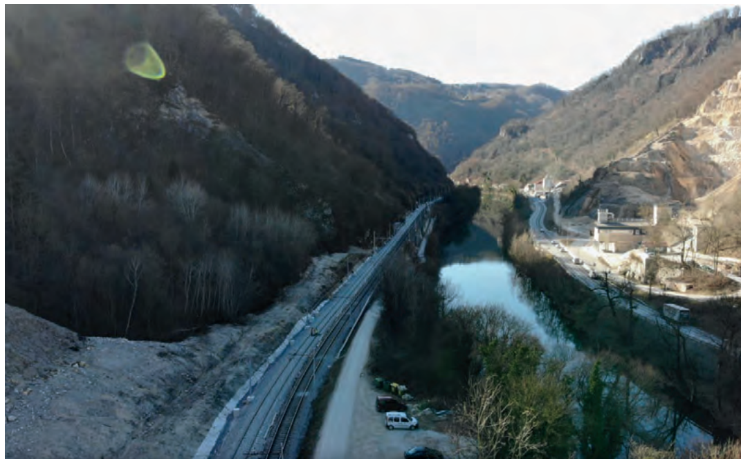
Sedmega februarja je bil za ves promet odprt desni tir med Zidanim Mostom in Rimskimi Toplicami. Dela na levem tiru se nadaljujejo marca.
