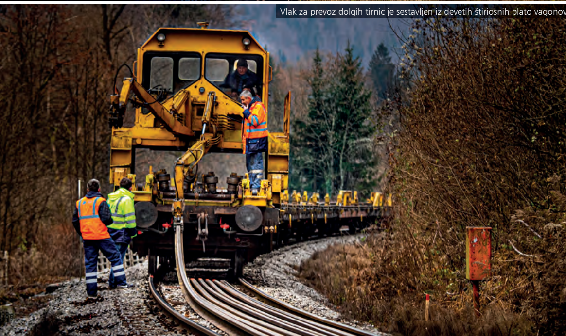
Lesene pragove bodo zamenjali novi, betonski.
