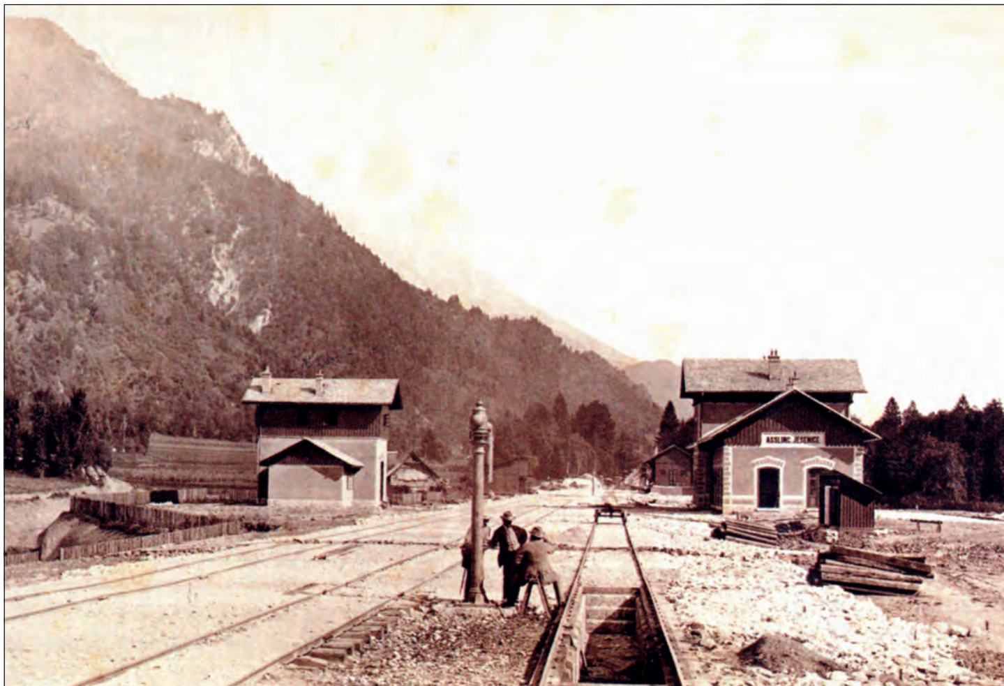
Ob odprtju proge leta 1870 so bile Jesenice le manj pomembna postaja, zato so dobile skromno postajno poslopje. Šele leta 1906 so z zgraditvijo Karavanško-Bohinjske proge postale pomembne in dobile novo, večje postajno poslopje. Današnje poslopje je že tretje, zgrajeno v slogu modernizma po 2. svetovni vojni, saj je nadomestilo porušeno prejšnje stavbo. (Slika iz knjige Rauter – Rainer Ein Verkehrsweg erschließt die Alpen, Zvezek 2, založba Mlakar, St. Peter pri Judenburgu, 1998.)
