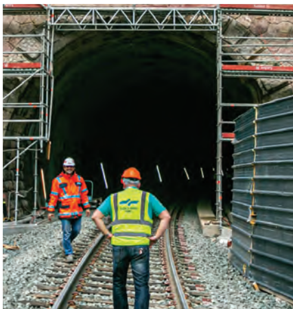
Dela v železniškem predoru Karavanke bodo končana kot načrtovano in proga skozenj odprta 10. julija. V predoru so postavljali signale in dokončevali zgornji ustroj proge. Večja gradbena dela so končana, nova proga je zgrajena, zdaj pa nadaljujejo dela na specifičnih detajlih v predoru.
