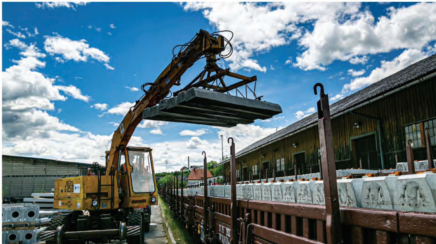
Ves gradbeni material, namenjen na gradbišča na gorenjski progi, se zbira v Kranju, nato pa ga prepeljejo na traso proti Podnartu. Na fotografiji nakladanje betonskih pragov.
