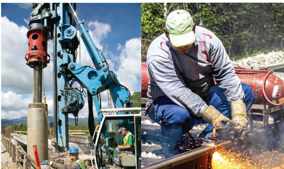
Do postaje Podnart je bila do konca maja proga že obnovljena. Dela se nadaljujejo proti Lescam, kjer se med drugim obnavljajo trije železniški objekti, postajališči Otoče in Globoko ter postaja Radviljica. Med nadgradnjo odseka Lesce–Jesenice so v začetku maja demontirali vse tire in vozno omrežje, na terenu je zdaj gradbena mehanizacija.
