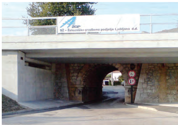
Dodatni betonski most se je na južni strani postavil pred starega in ga, starčka, vzel v zaščito.
