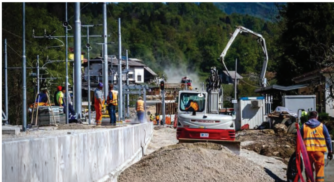
Pri posodobitvi proge Zidani Most–Rimske Toplice je bilo podjetje SŽ-ŽGP zaradi dobrega in učinkovitega dela na državni ravni poudarjeni kot zgled dobre prakse v gradbeniški panogi. (foto: Miško Kranjec)
