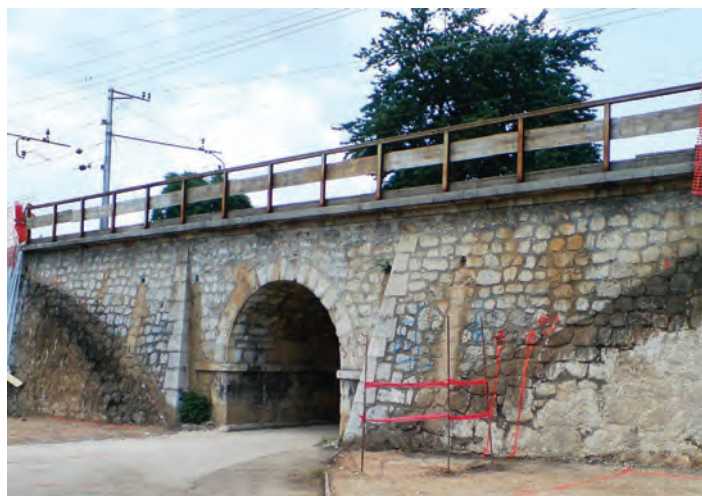
Podvoz v Zeleni Jami so ob gradnji dodatnega mostu razgalili, da je zasijal v vsej svoji kamniti lepoti.
