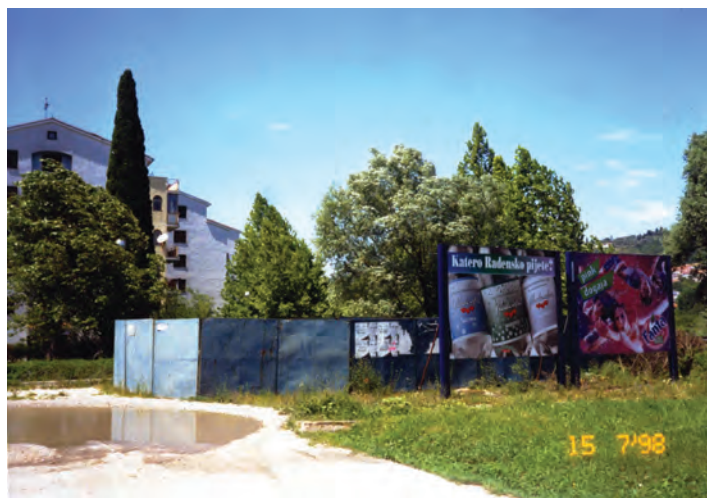
Gradbena ograja z deponiranim kamenjem nekdanje postaje Lucija »300 metrov stran«
