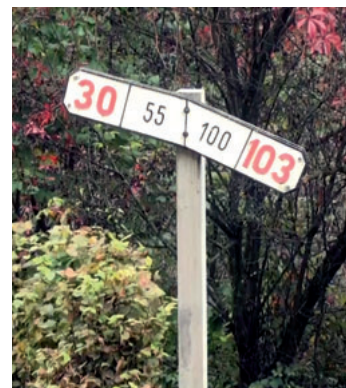
Znak za naklon proge: 55m - 30‰ na postaji, 100 m - 105‰ na odprti progi
