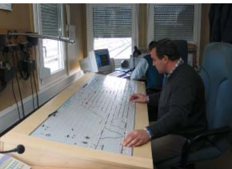
Vodenje prometa na razširjeni postaji že poteka z novo postavljalno mizo – za zdaj v kontejnerju ob obstoječi postajni zgradbi.
