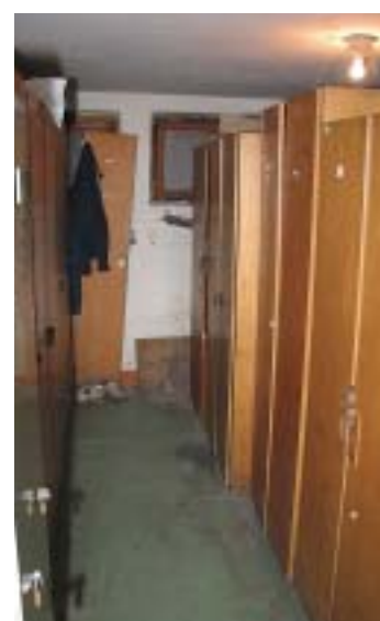
Garderoba ima svoj prostor(ček) v kleti. Za obnovo postajne stavbe je res že skrajni čas.
