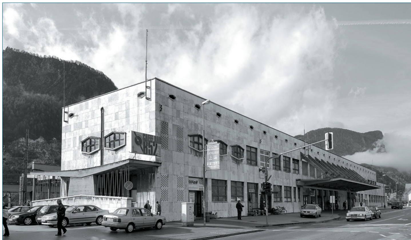
Stavba železniške postaje Jesenice (foto: Miran Kambič)
