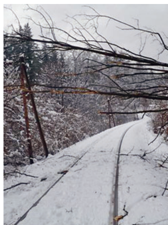
Slabo očiščen progovni pas
