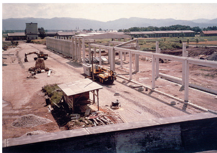
Med gradnjo strugarne; stružnica je bila položena na temelje in zaščitena z leseno konstrukcijo.
