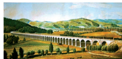
Pesnica viadukt na aborelu Ferdinanda Jungblutha Vrh avtor: Mladena Bogića
