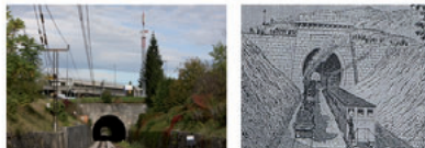
Predor Šentilj s severne strani in Buserstunnel pri Gumpoldskirchenu na italijanski Wlen-Gloggnitzer Vrh. foto Andrej Premaš in Duitinger, 1985
