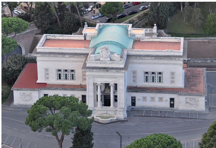
Poslopje vatikanske železniške postaje
