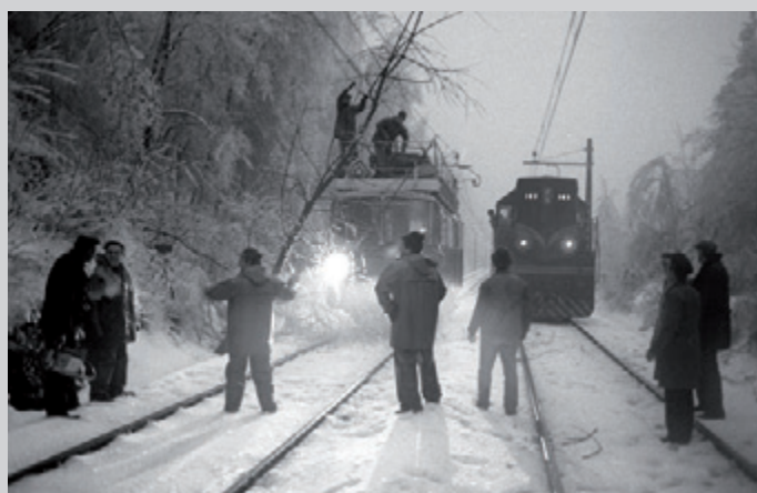
Žled in sneg na progi Borovnica-Verd, 17. decembra 1983 (foto: Miško Kranjec, Delo, hrani MNZ)
