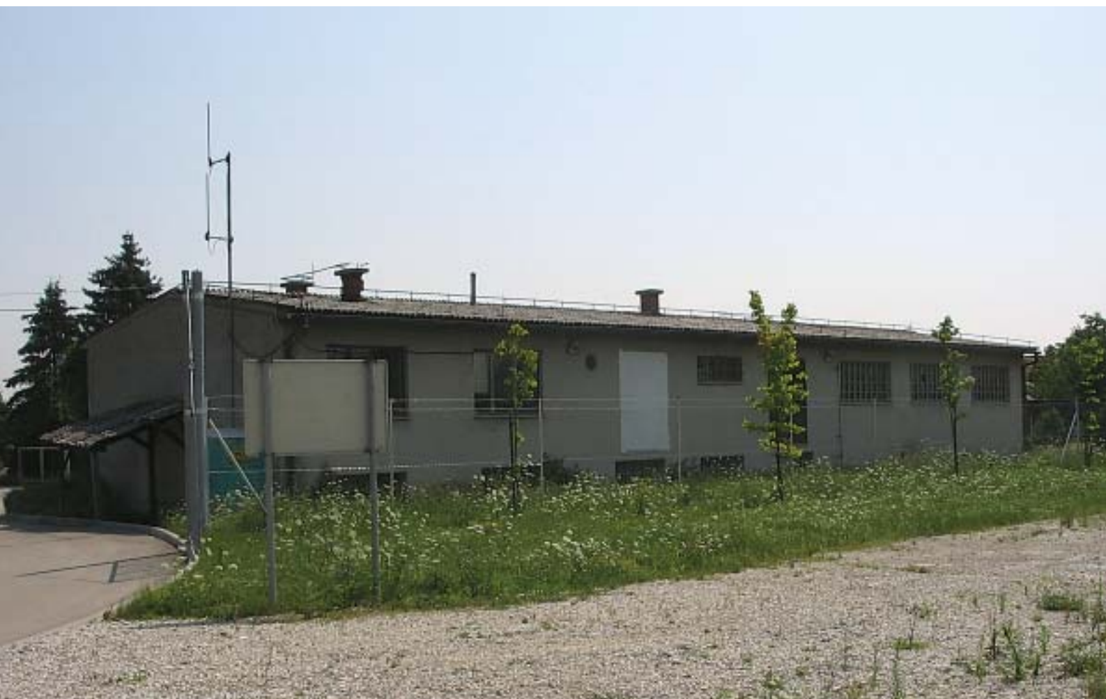
V tej stavbi so trenutno nameščeni delavci tovornega prometa v Dobovi.
