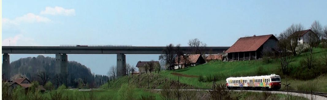
Proga pod avtocesto proti Škofljici
