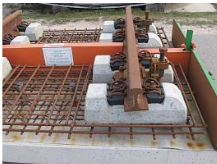
Sistem pritrdjevanja tirnic po metodi Rheda 2000 na novozgrajenem odseku HSL Zuid bo dovoljeval vožnje do hitrosti 300 kilometrov na uro.
