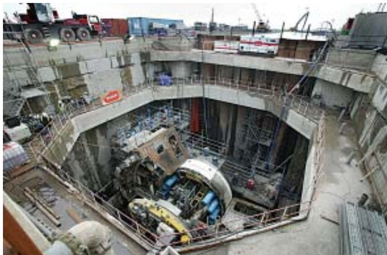
Orjaški vrtni sveder Aurora s premerom vrtnice 14,87 metra gloda mehko sredico novega predora Groene Hart tunnel, ki s svojim vkopom dolžine 1.510 metrov preide v predor, dolg 7.160 metrov, ki leži med 15 in 35 metrov pod morsko gladino!
