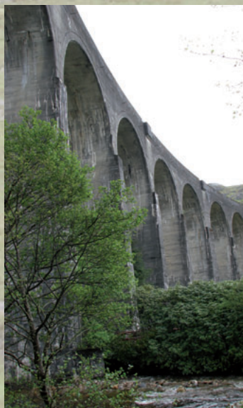
Betonski viadukt tvori 21 lokov.
