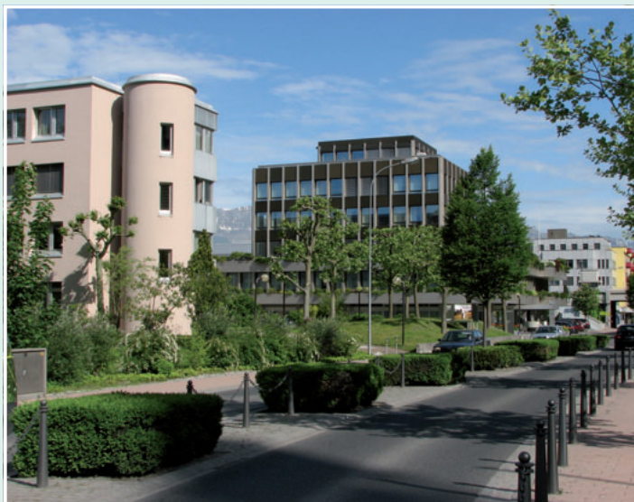
Obrobje Vaduza zaznamujejo poslovne stavbe.
