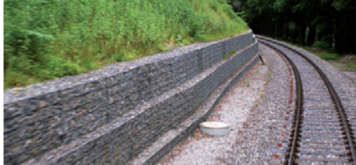
Novo zgrajeni podporni zid
