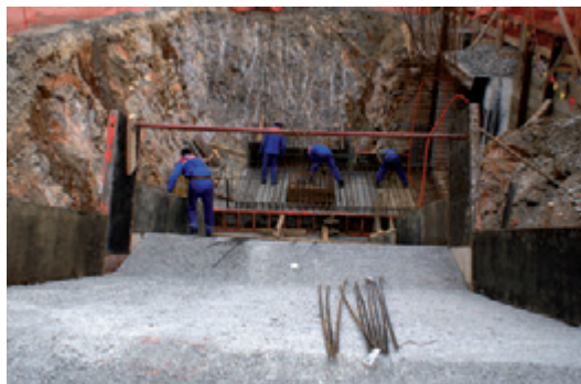
Gradnja potniškega podhoda v Ribnici
