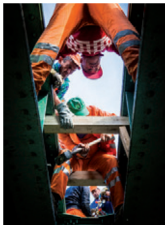
Montaža lesenega opaža na začasnem mostu.
