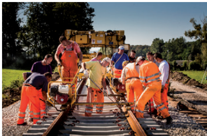
Polaganje pragov in montaža tirnic.
