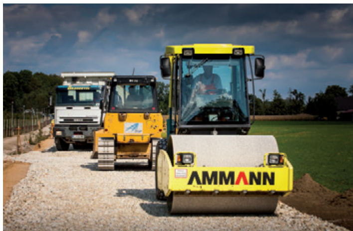
Spodnji del nove gramozne grede se pripravlja za polaganje pragov.
