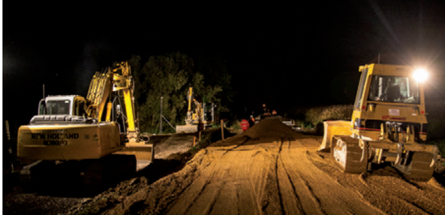
Sobotna noč – stari stroj je odstranjen in polaga se nov tampon.
