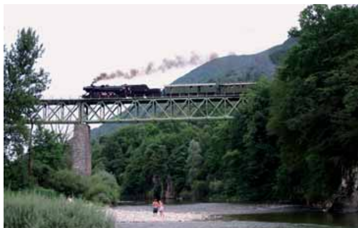
Lokomotiva 33-037 na viaduktu Most na Soči. (1. julij 2007).
