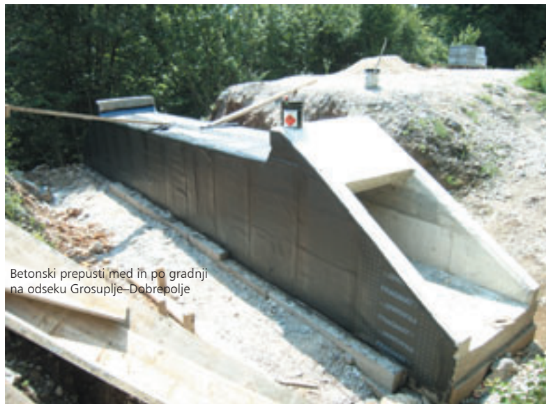
Obnovljen cestni prehod. Večina cestnih prehodov je opremljena z gumijastimi podlogami.
