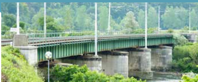
Slika 11: Polnostenski jekleni most čez Savinjo pri Tremerju danes. l = 112 m
