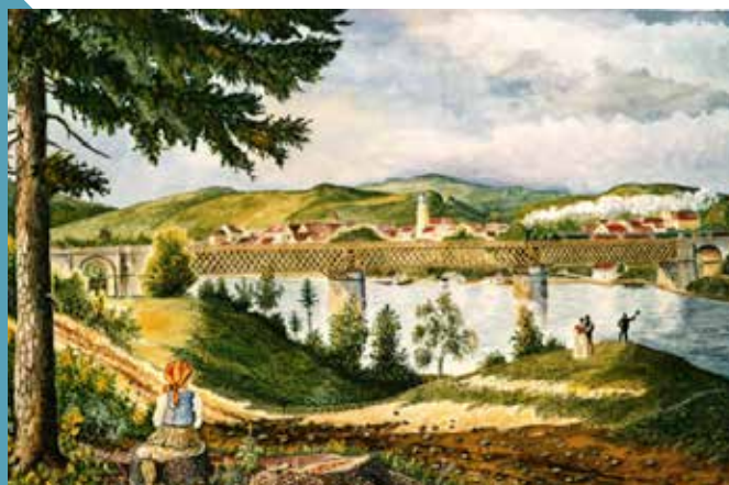
Slika 5: Leseni most tipa Howe čez Dravo v Mariboru, akvarel: Sepp Tezak
