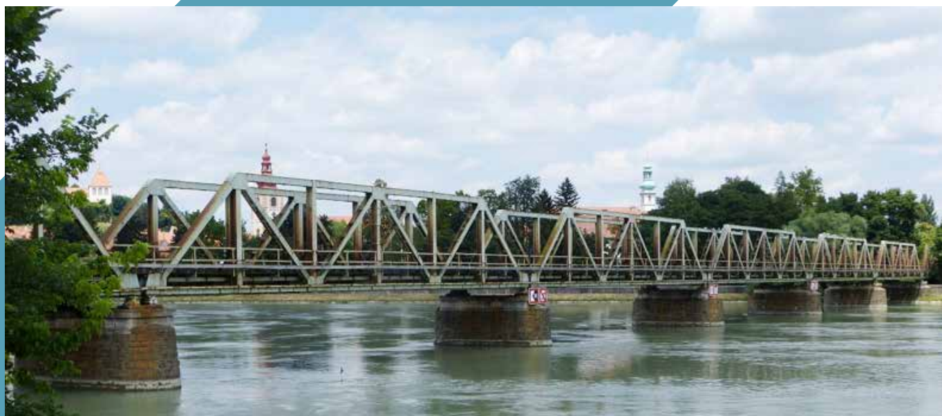
Slika 22: Današnji most preko Drave na Ptuj je sestavljen iz sedmih polj s trapeznimi nosilci, ki merijo 26.63 + 5 \times 31.98 + 26.63 m.
