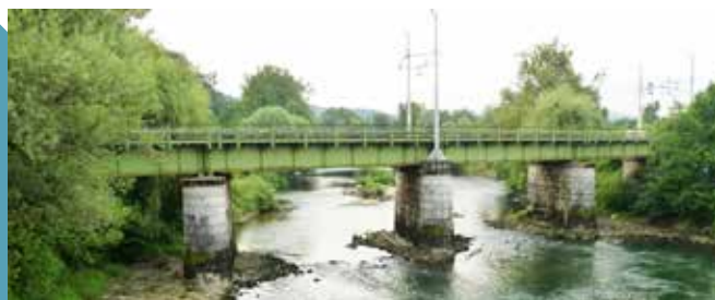
Slika 12: Polnostenski jekleni most čez Ljubljanico v Zalogu danes. l = 64,5 m
