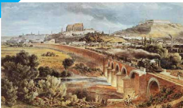
Slika 1: Ghenga – Viadukt KfNB pred Brnom, l = 637 m, 72 lokov, 1838, vir Lit. 10, str. 101
