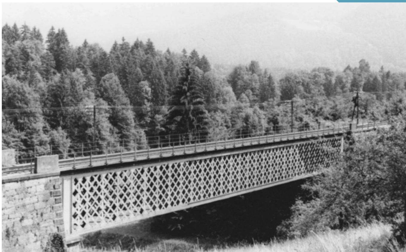
Slika 25: Most čez potok Ilgo pri Fali, dolg 48,30 m, je tipičen predstavnik rešetkastih mostov, kovinskih »latnikov«, na obdravski progi. Foto Sepp Tezak
