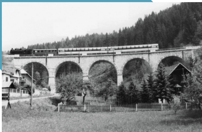
Slika 24: Nad cesto, ki vodi v Šentanel, se boči nenavadno lepi Štoparjev viadukt, dolg 77 m. Ime je dobil po avtorju arhitektu. Tudi ta je pod spomeniškim varstvom. Posnetek s posebnim muzejskim vlakom s švicarskima razglednima vagonoma je leta 1991 napravil prof. Sepp Tezak iz Gradca
