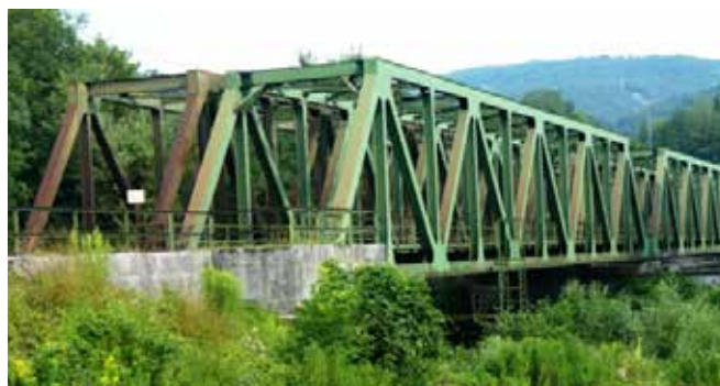
Slika 8: Leseni litijski most so 1898 zamenjali z jekleno rešetkasto konstrukcijo, ki je morala v življenju pretrpeti marsikaj, celo uničujoč združen napad partizanov in zavezniškega letalstva 20. septembra 1944. Vedno znova so ga obnavljali, tako da zdaj stojita druga ob drugi tretja in četrta generacija mostov.
