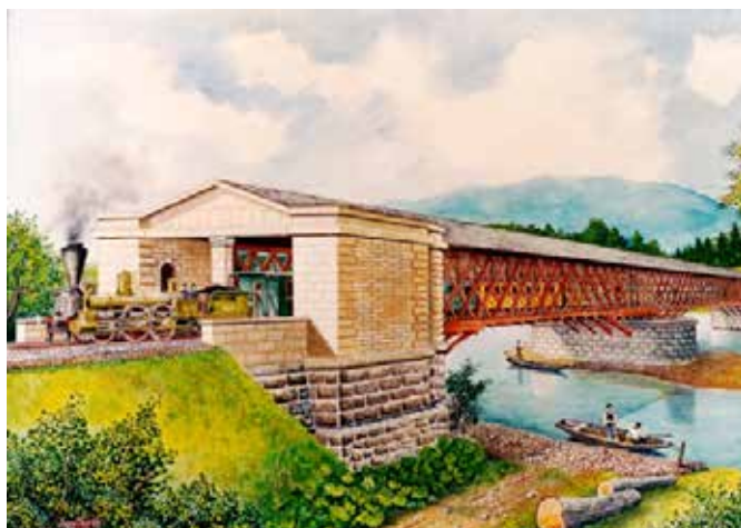
Slika 7: Leseni most tipa Howe čez Savo pri Pogoniku, l = 164 m, akvarel: Sepp Tezak
