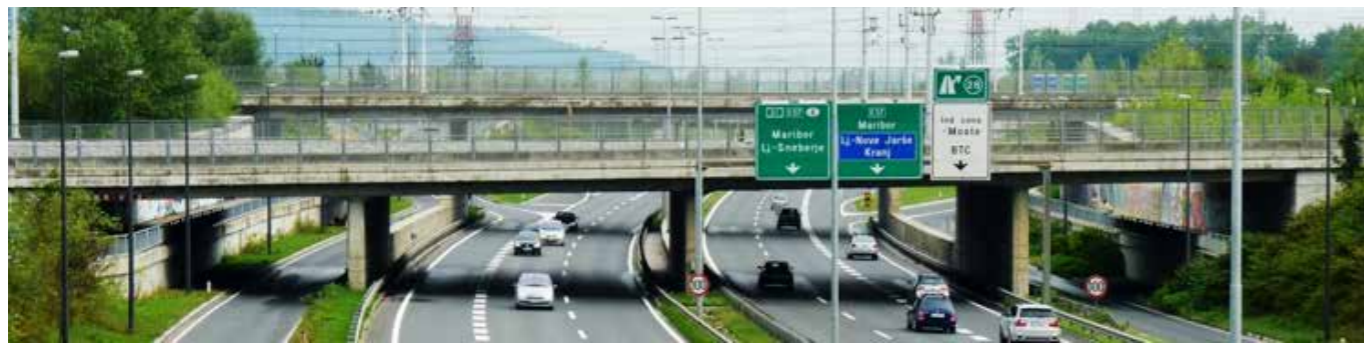
Slika 48: Armiranobetonska nadvoza čez ljubljansko vzhodno obvoznico sta dolga 60 m in ju je v letih 1996/97 zgradilo podjetje Gradis. Foto: Mladen Bogič
