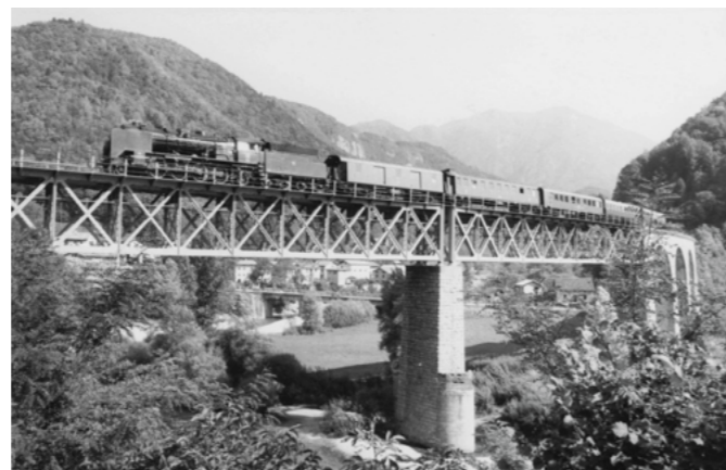
Slika 32: Most čez Idrijco pred postajo Most na Soči je kombiniran – čez strugo sega jeklena konstrukcija, do njega vodi na severni strani kamniti viadukt s sedmimi loki, na južnem bregu pa kompozicijo zaključuje še en kamnit lok. Skupna dolžina je 258 m. Prof. Sepp Tezak je v devetdesetih letih prejšnjega stoletja na mostu posnel muzejski vlak SŽ.
