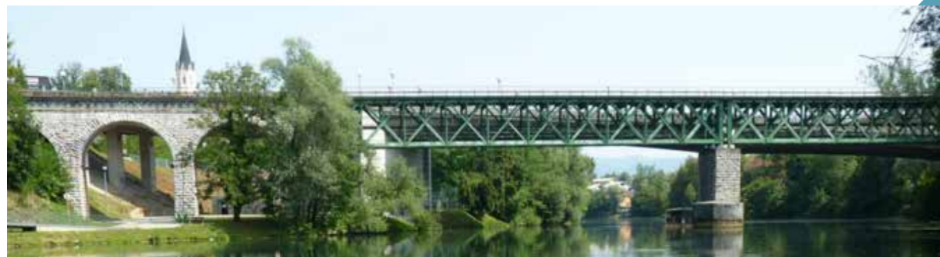
Slika 38: Most čez Krko v Novem mestu je kombiniran; čez vodo segata dve jekleni konstrukciji po 48 m, na vsakem bregu pa je 42-metrski pristopni viadukt s po tremi loki. Most se skladno vklaplja v okolico in je estetsko polnovreden. Foto: Mladen Bogič
