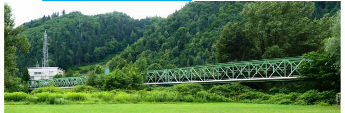
Slika 28: Most čez Savo na progi Kranj–Naklo sega tudi čez inundacijsko območje in je sestavljen iz štirih enakih rešetkastih konstrukcij v skupni dolžini 168 m. Foto: Mladen Bogič
