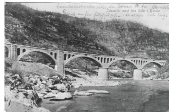
Sliki 34, 35: Prvotni most čez Sočo pri Ajbi spominja na kamnite čipke, dolge 242,5 m. Deluje nenavadno lahkotno in vitko. V obeh vojnah je bil delno porušen, tako da so že leta 1954 poleg za silo popravljenega starega zgradili nov most. Nov most, ki ga je projektiral ing. Feliks Vrečko, nima razbremenilnih obokov, zato učinkuje bolj masivno, vendar mu ni mogoče odrekati elegancije. Razglednica starega mostu je v zbirki Železniškega muzeja SŽ, novi most pa je fotografiral Radivoj Pleterski.
