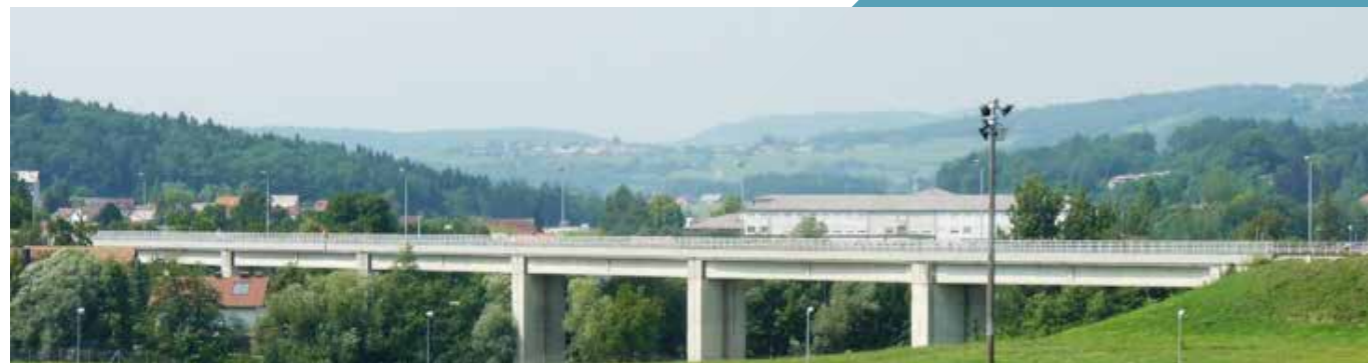
Slika 39: Armiranobetonski gredni most v tovarno Revoz čez Težko vodo v Novem mestu je bil odprt šele 25. 4. 1980 in je z dolžino 573 m najdaljši železniški most v Sloveniji. Kljub svoji utilitaristični strogosti deluje skladno in elegantno. Foto: Mladen Bogič
