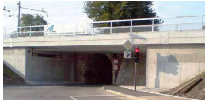
Slika 47: ... potem pa je Gradis leta 2009 zgradil nov most in stari je izginil v betonskem oklepu. Foto: Mladen Bogič
