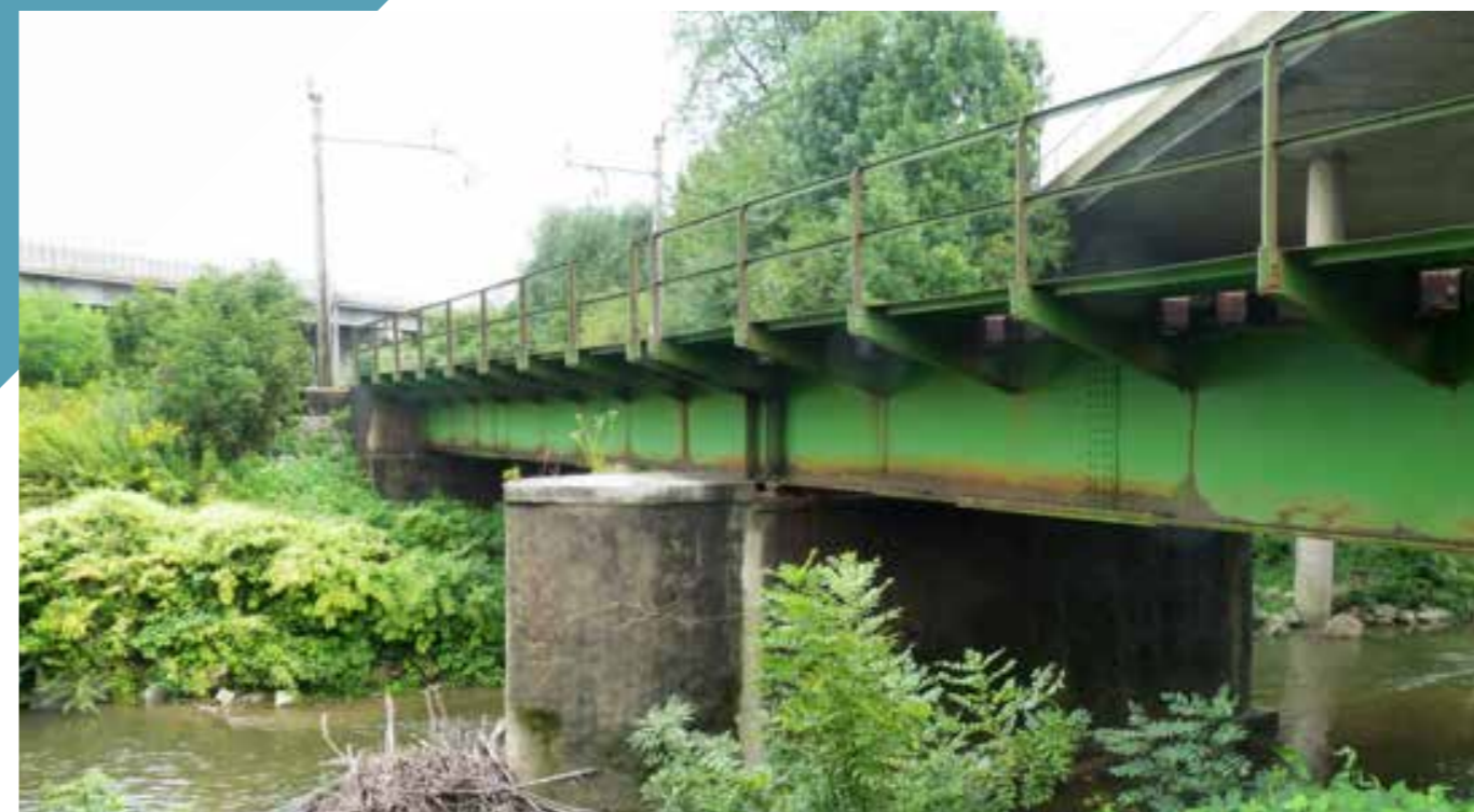
Slika 41: Železniški most čez Mali graben je sestavljen iz jeklenih polnostenskih nosilcev dolžine 2x15,5 m. Foto: Mladen Bogič
