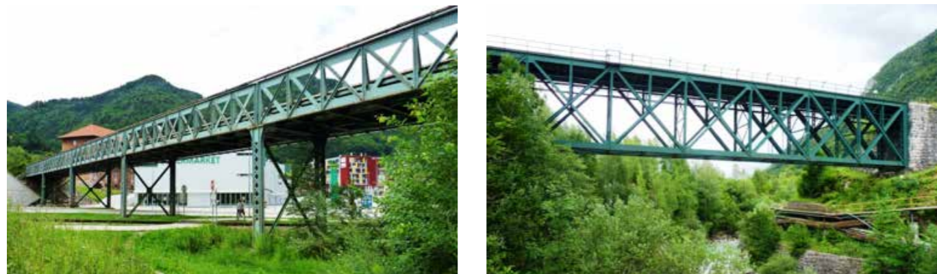
Slika 30: Jesenice: dostopni jekleni viadukt meri 82 m, most čez Savo Dolinko pa 72 m. Foto: Mladen Bogič
