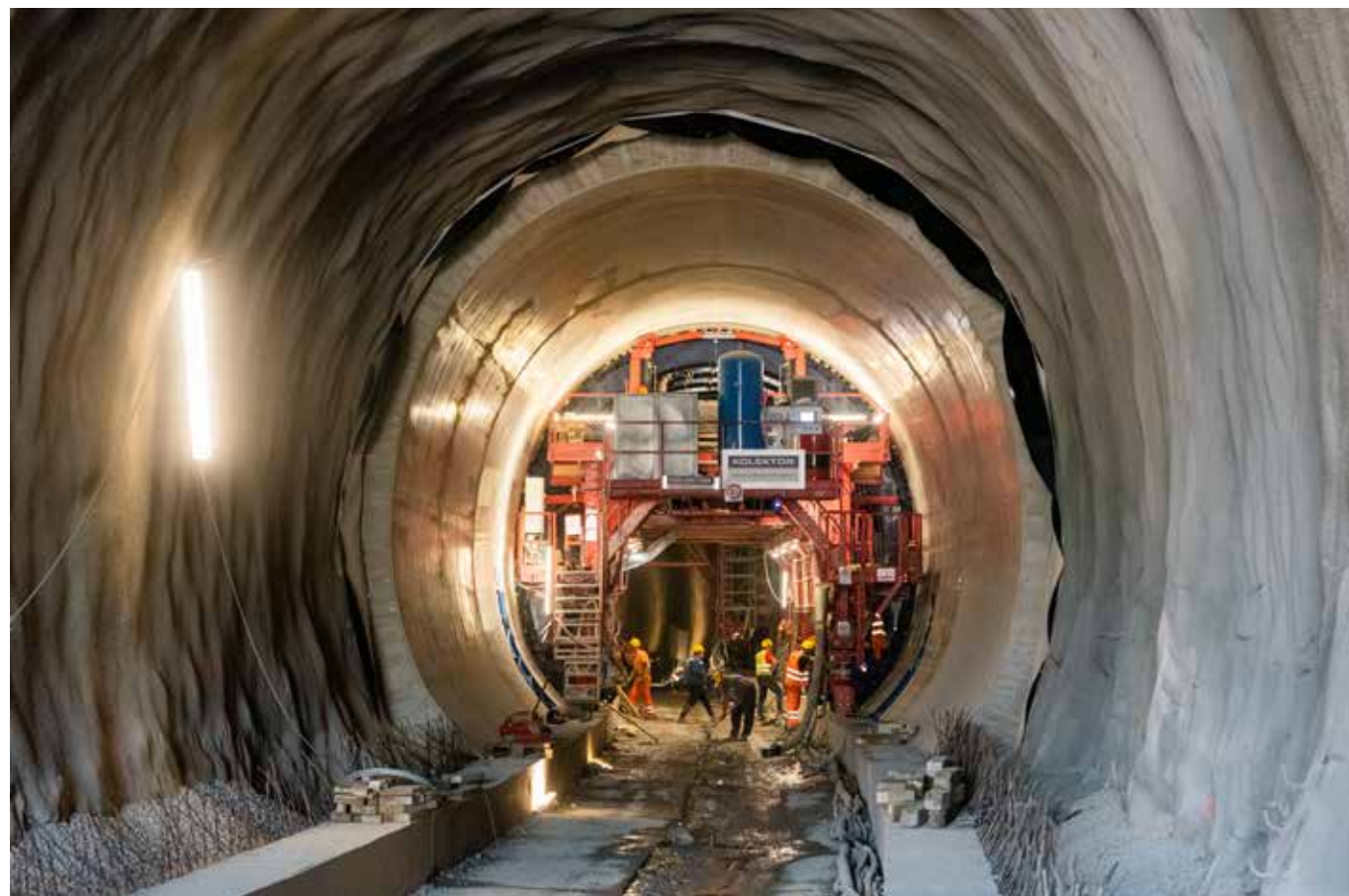
Po izkopu predorov sledi izdelava notranje obloge, s katero predor dobi značilno in enakomerno obliko
