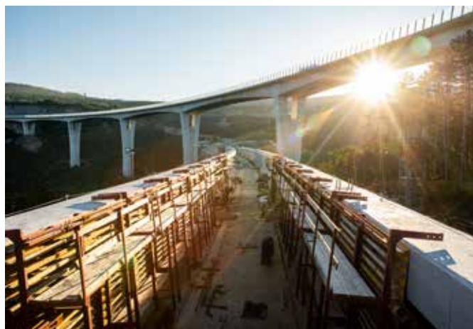
Viadukt Gabrovica premošča Osapsko dolino in v dolžino meri 416 metrov.
