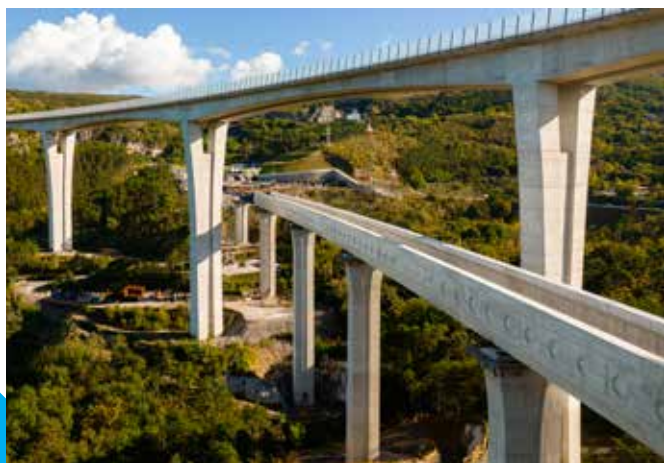
Voziščna konstrukcija viadukta je sestavljena iz 13 segmentov, ki so v povprečju dolgi 32 metrov.
