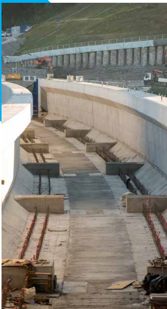
Voziščna konstrukcija viadukta je zasnovana v obliki betonskega korita, ki posnema črko U.
