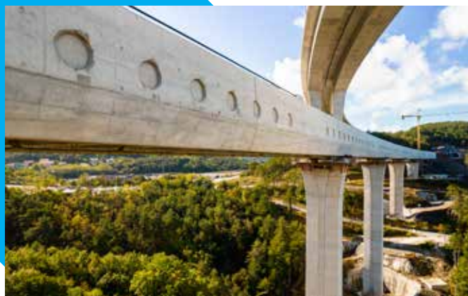
Stebri viadukta v višino merijo od 13 do 64 metrov.
