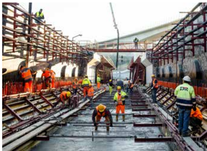
Betoniranje segmenta voziščne konstrukcije viadukta.
