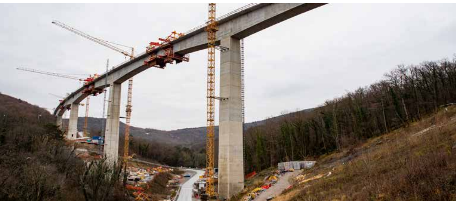
Voziščna konstrukcija viadukta Vinjan je zaključena
