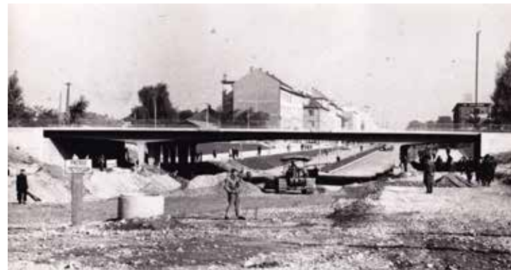
Jesen 1962: nadvoz na Titovi dokončan – gre tako za konstrukcijski kot oblikovalski dosežek.
