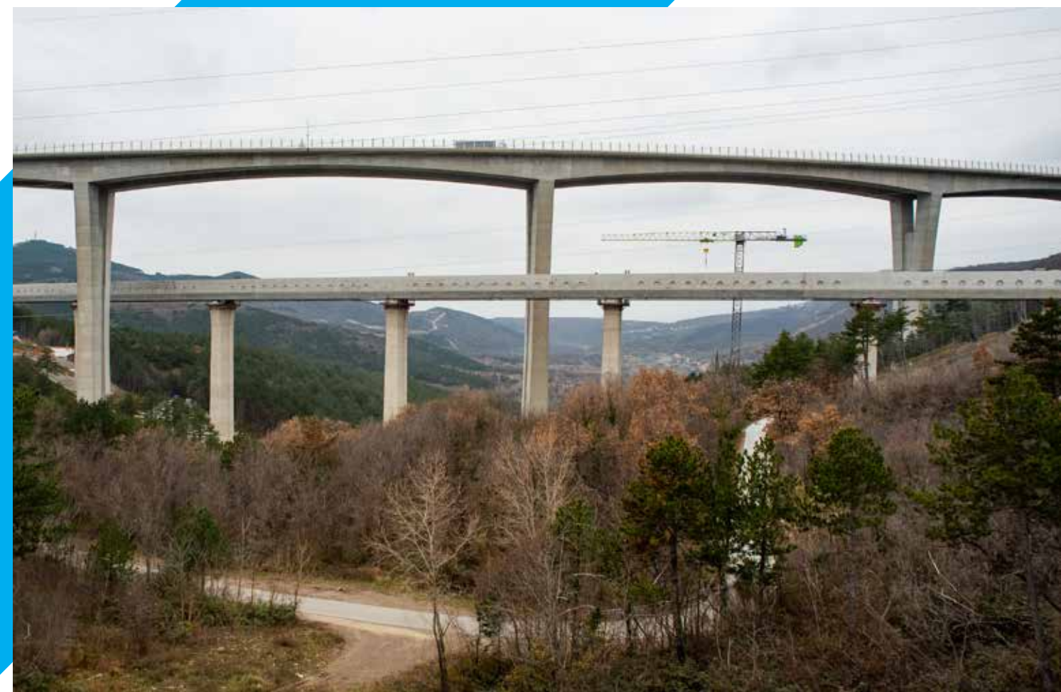
Železniški viadukt Gabrovica poteka pod črnokalskim avtocestnim viaduktom
