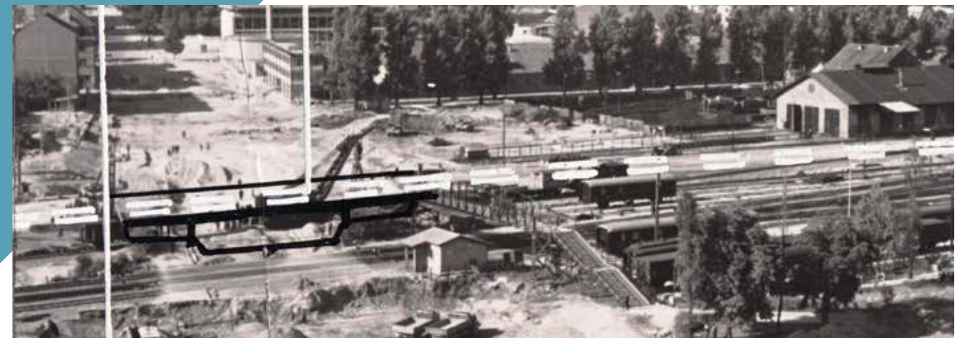
Spomladi 1962 se je ponujala takšna slika začetnih del pri gradnji nadvoza na Titovi cesti
