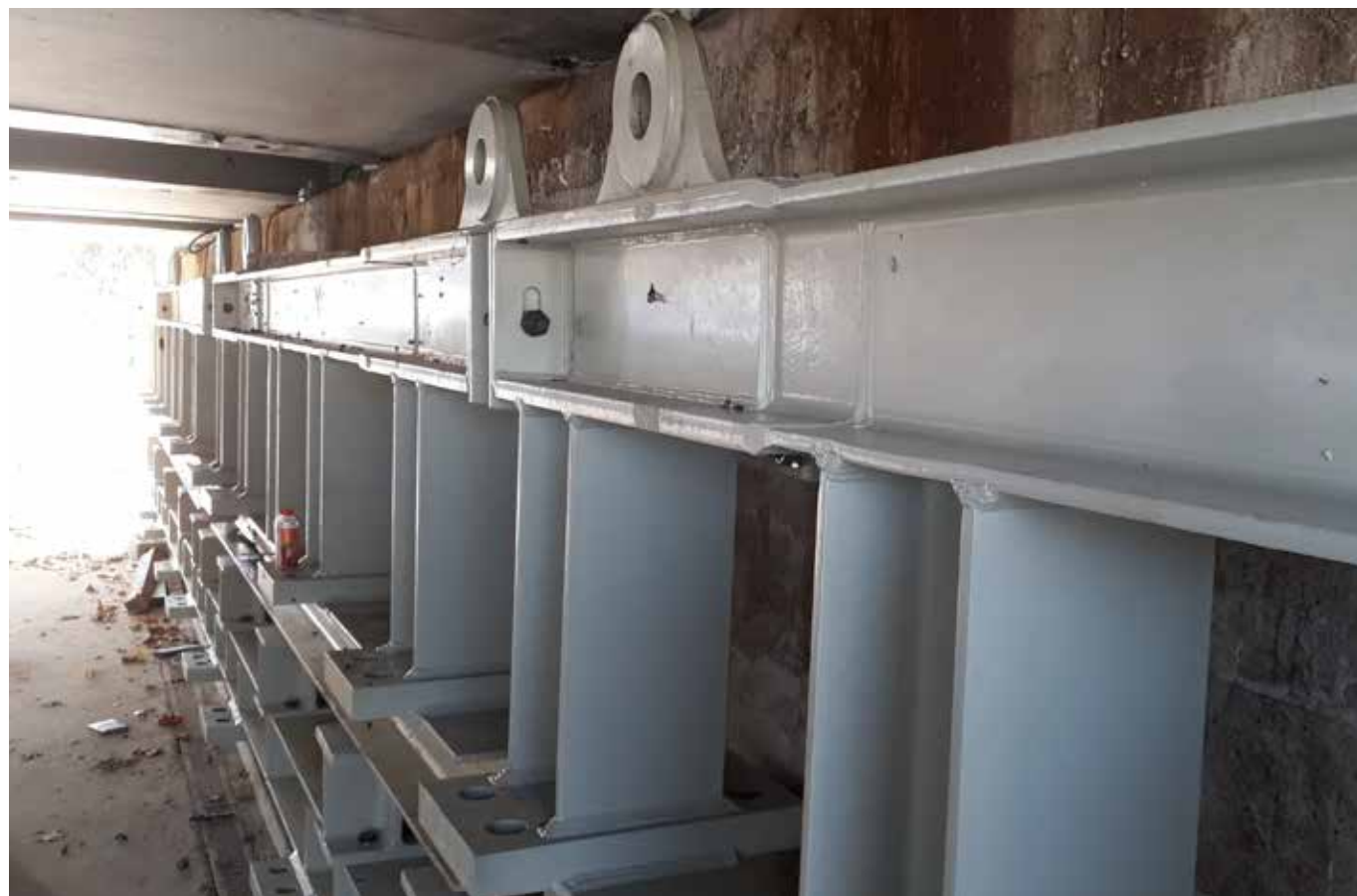
Saniranje sidranja stranskih opornikov jeseni 2020 je bilo masiven ukrep
