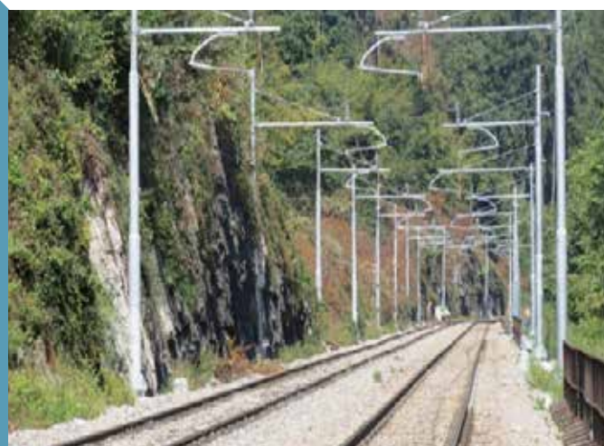
Borovnica-Verd – stanje po sanaciji
