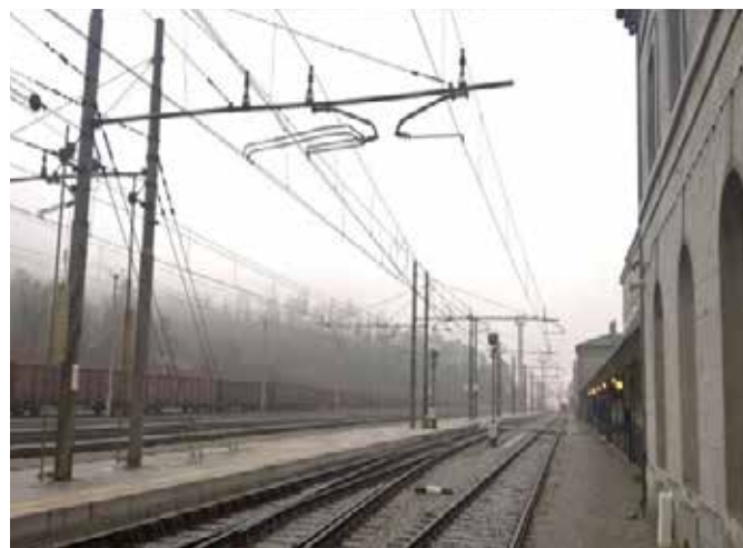
Pivka – stanje po sanaciji
