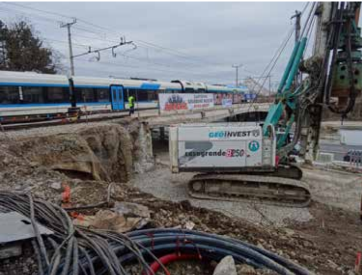
Polovica starega železniškega nadvoza na Dunajski cesti v Ljubljani je odstranjena in začenjajo se priprave za gradnjo novega. (foto Josip Orbanic)
