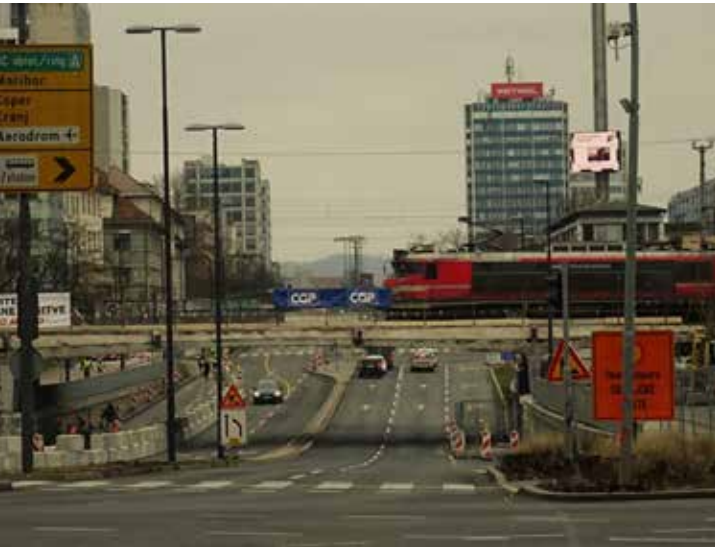
Pogled na železniški nadvoz po odstranitvi leve polovice. S tem se je začela gradnja novega Potniškega centra Ljubljana, ki se nadaljuje v letu 2024 in se bo zaključila predvidoma v dveh letih. (foto Josip Orbanic)
