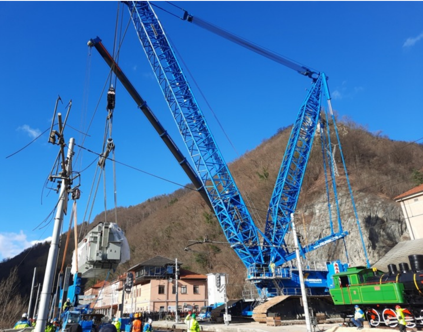
Reševanje prevrnjenega transformatorja v Zidanem Mostu februarja 2023 s posebnim dvigalom, ki je bilo sestavljeno na sami lokaciji. (foto K. Ponikvar in B. Dremelj)
