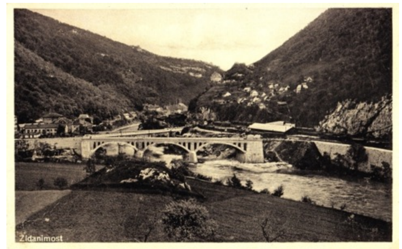
Novi betonski most čez Savinjo v Zidanem Mostu. (razglednica iz zbirke avtorja)
