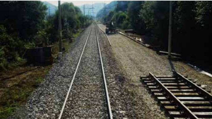
Sanacija proge Zidani Most–Ljubljana po poplavi pri Litiji. (foto Josip Orbanic)
