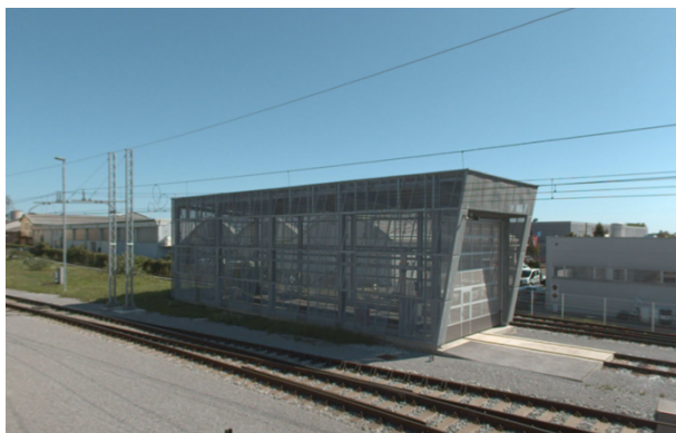
Izgled stavbe garaže progovnih vozil
