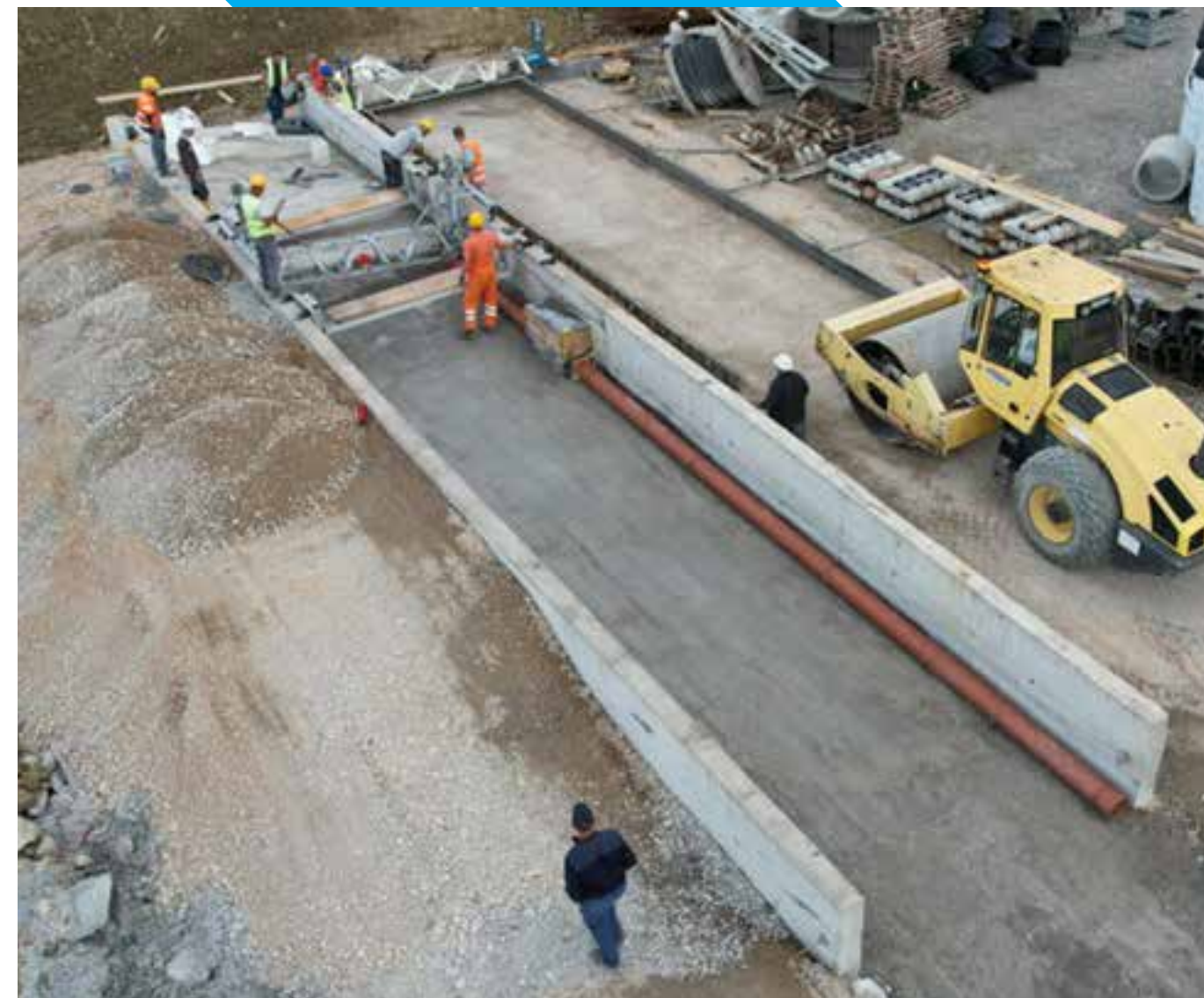
Testno polje za vgradnjo tira na togi podlagi
