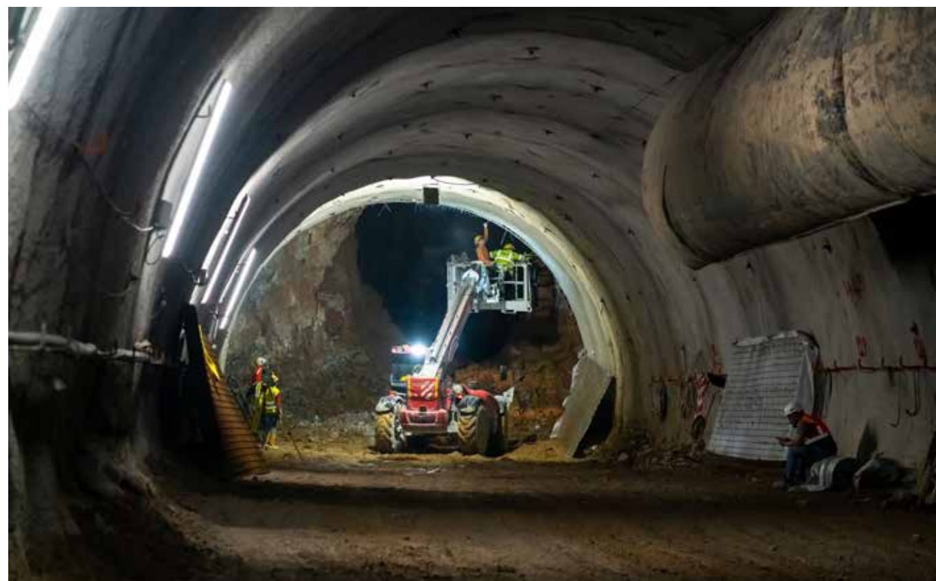
Pri izkopu predorov se je naletelo na skoraj 90 kraških pojavov.
