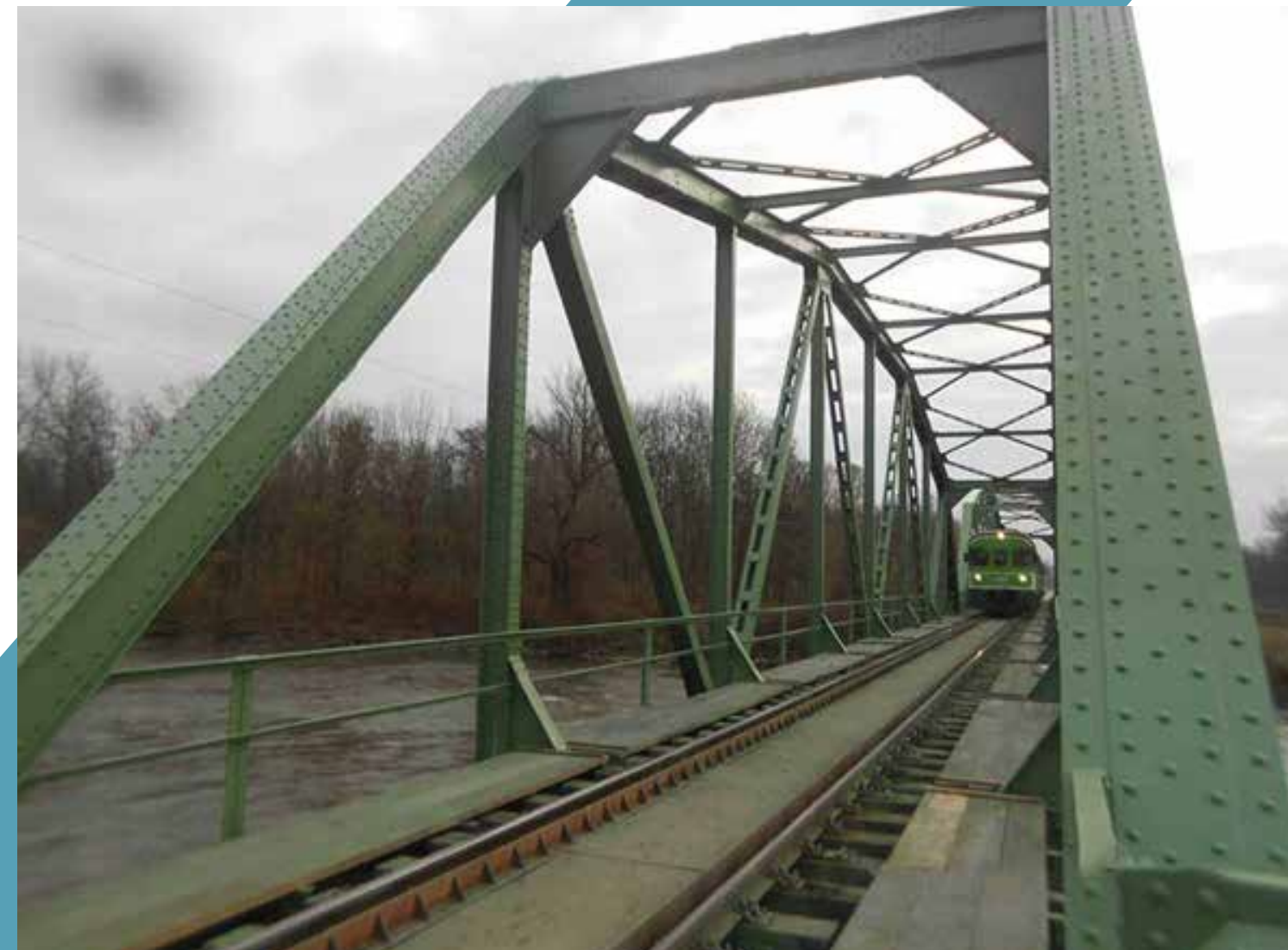
Železniški most preko Mure, vir: Inštitut za metalne konstrukcije, 23. 7. 2024.
