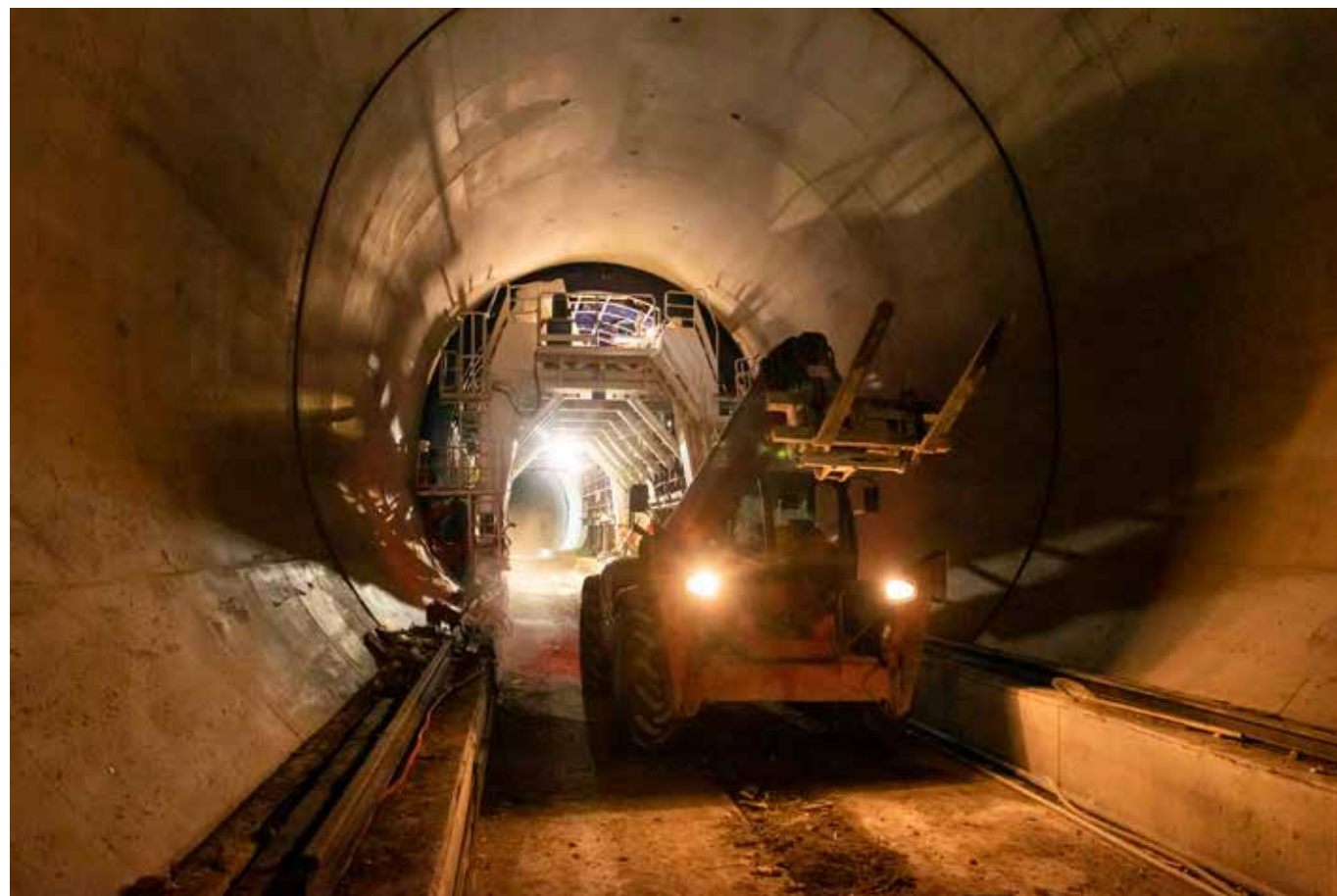
Vsi predori na progi so prebiti, v večini zdaj poteka izvedba notranje obloge.
