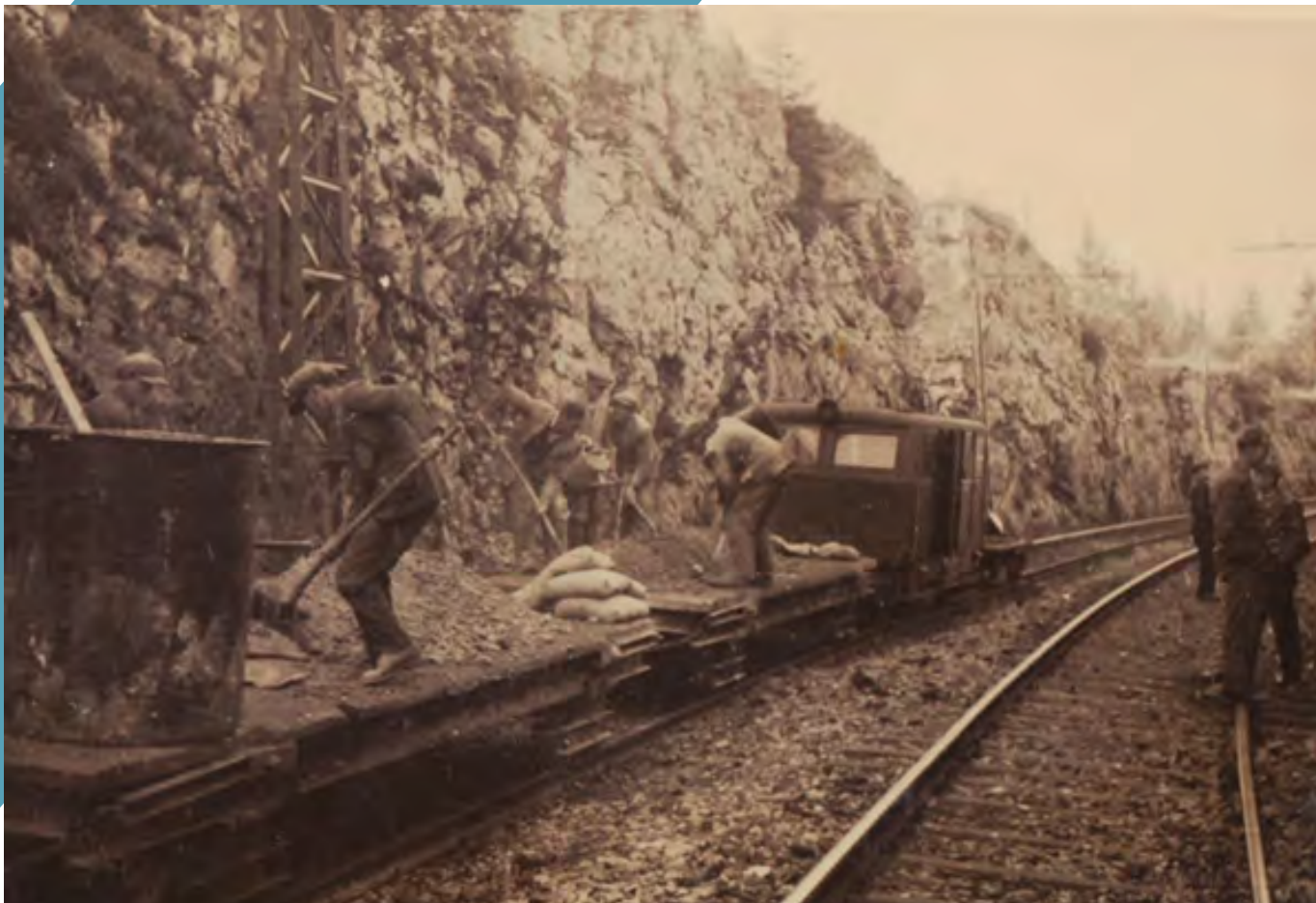
Zasipavanje temeljev portala. Vidimo ročno delo in tedanjo opremo in vozila (zbirka avtorja, zapuščina Draga Smrketa)
