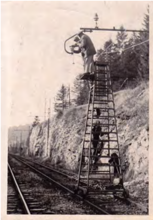
Montaža polygonacijskih ročic na Ravbarkomandi pri Postojni (iz arhiva Uredništva železniškega tiska, 1954)
