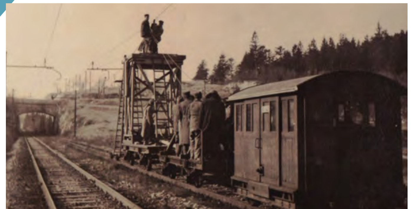
Raztezanje vodnikov vozne mreže (zbirka avtorja, zapuščina Draga Smrketa)
