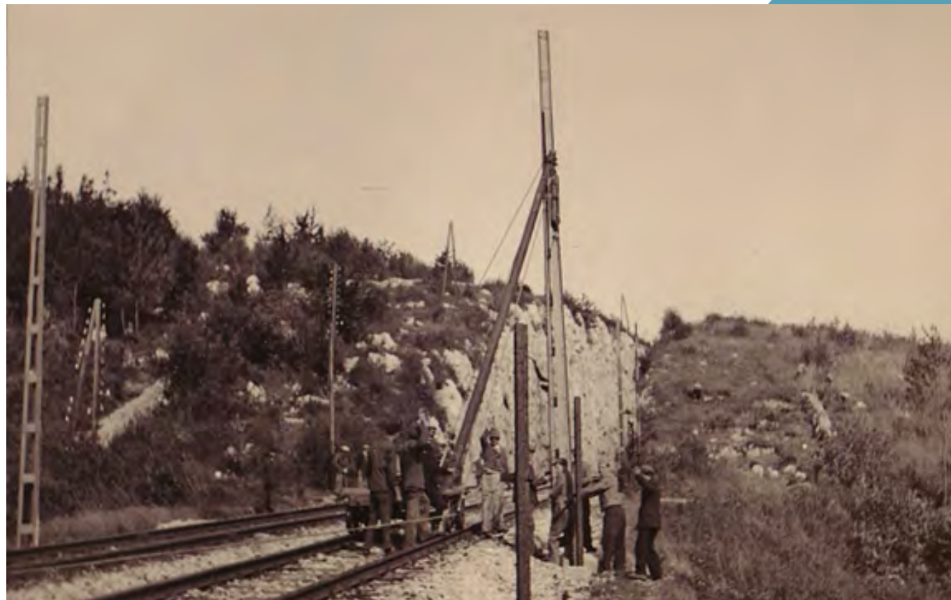
Postavljanje droga vozne mreže (zbirka avtorja, zapuščina Draga Smrketa)
