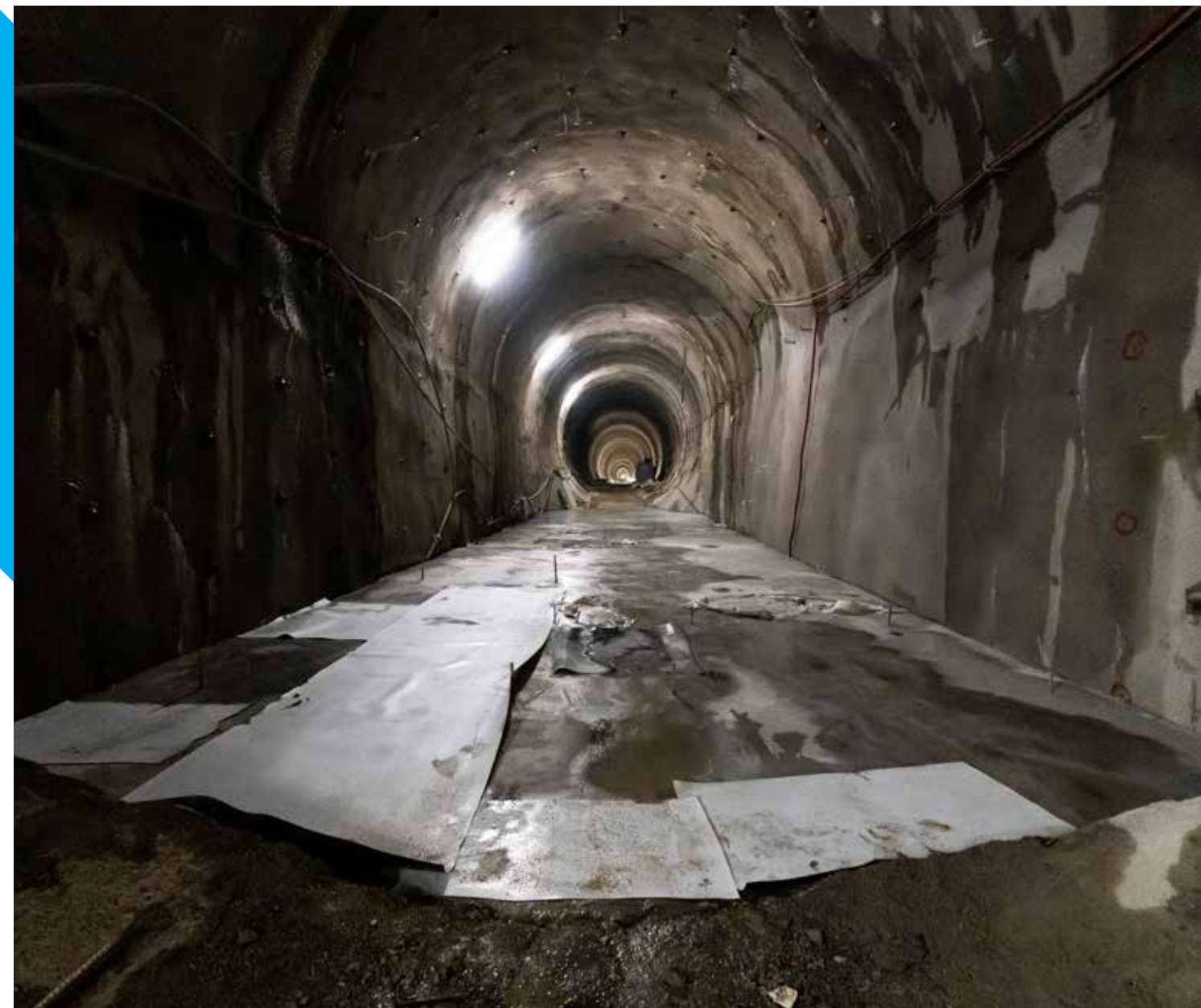
Vsi dodatni ukrepi, ko govorimo o premoščanju kraških jam in pri pomikih hribine, so namenjeni varovanju zgrajenih infrastrukturnih objektov na trasi drugega tira ter omogočanju varnega železniškega prometa v prihodnosti.
