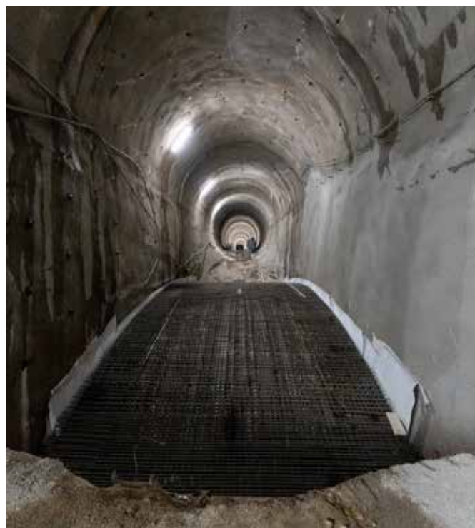
Armatura za premostitev jame št. 66 v glavni cevi predora Beka (T2) je položena.
