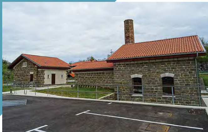
Obnovljeni objekti (foto: Orbanic, 2021)
