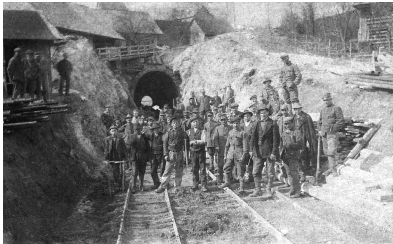
Na fotografiji je železniški predor pod hribom Naklo v Logatcu.
