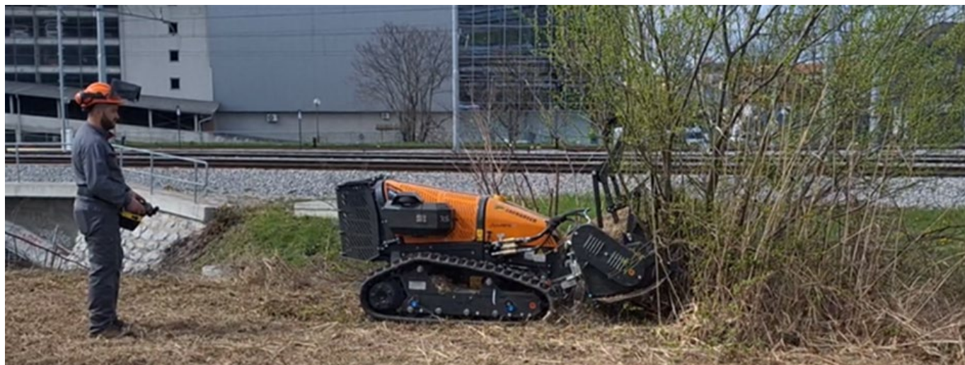
Prikaz upravljanja samohodnega mulčerja na terenu. Vir: arhiv SŽ - Infrastruktura
