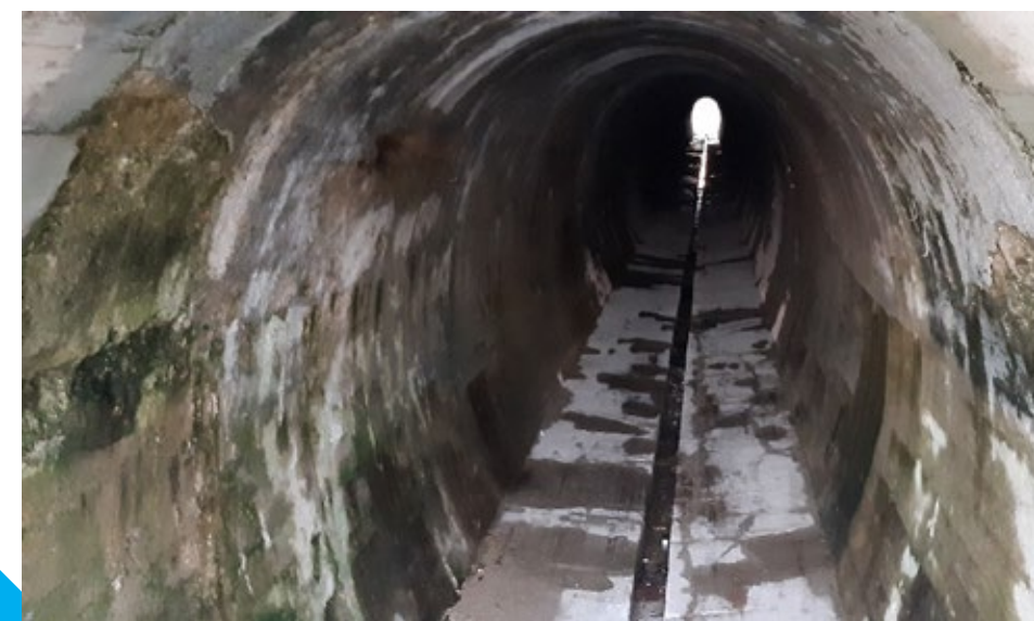
Notranjost predora s kineto za odvodnjavanje (foto: Tone Jerina)
